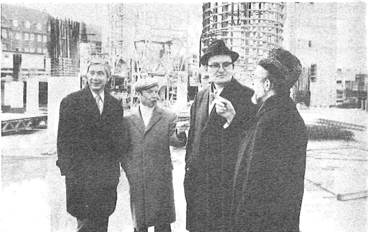
Erst in diesen Tagen konnten wir uns bei einer Besichtigung von dem Stand der Bauarbeiten auf der Großbaustelle Ihme-Zentrum unterrichten. Die Erläuterungen gab Dr. Carl Schaezle (zweiter von links), Chef der City Bau KG Leverkusen. Foto: Bert Schreurs
