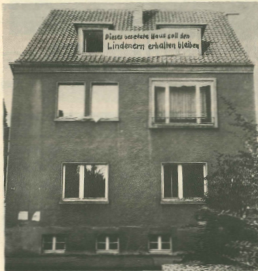
Forderung vor den Dachkammern. Besetztes Haus Kaplanstraße 21.
