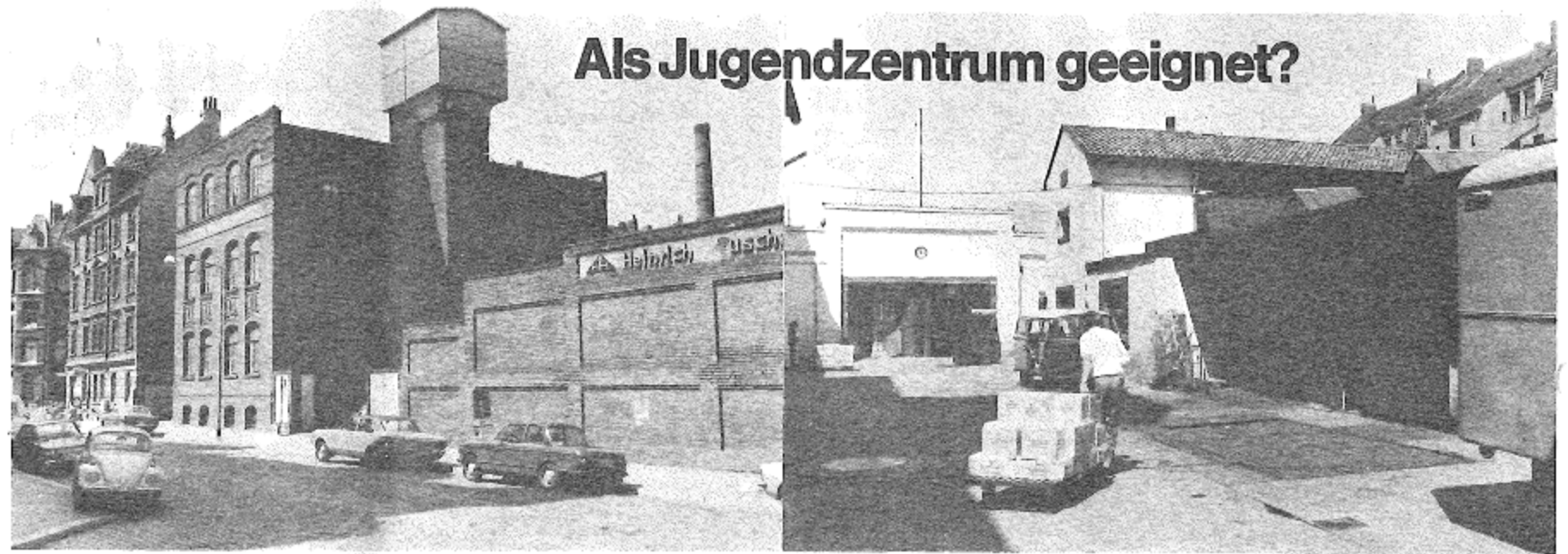
Das Fabrikgebäude mit dem Wasserbehälter macht noch einen ganz stabilen Eindruck, doch die verschachtelten Hofschuppen (rechts) sind durch Feuchtigkeit, gegen die schon viel — vergeblich — unternommen wurde, unbrauchbar.
