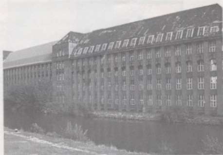
Die Bebauung des Conti-Geländes wird Limmer verändern
