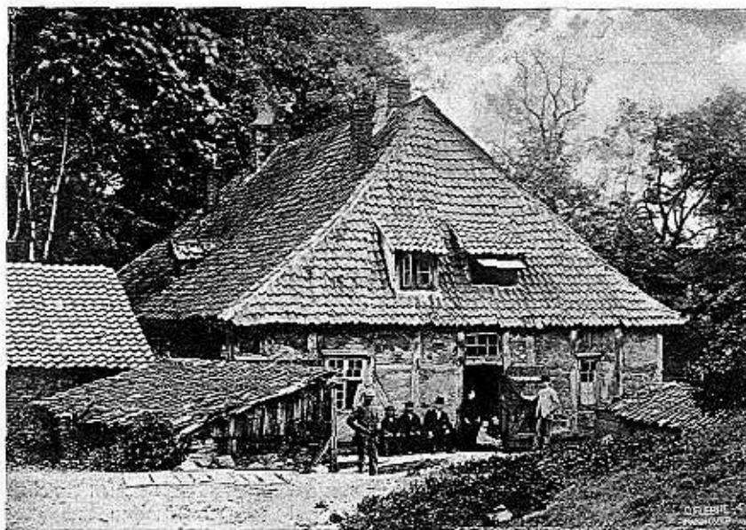
Der Brauhof. Ehemaliges Torfhaus.
