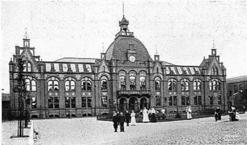
Direktionsgebäude der Hanomag.
