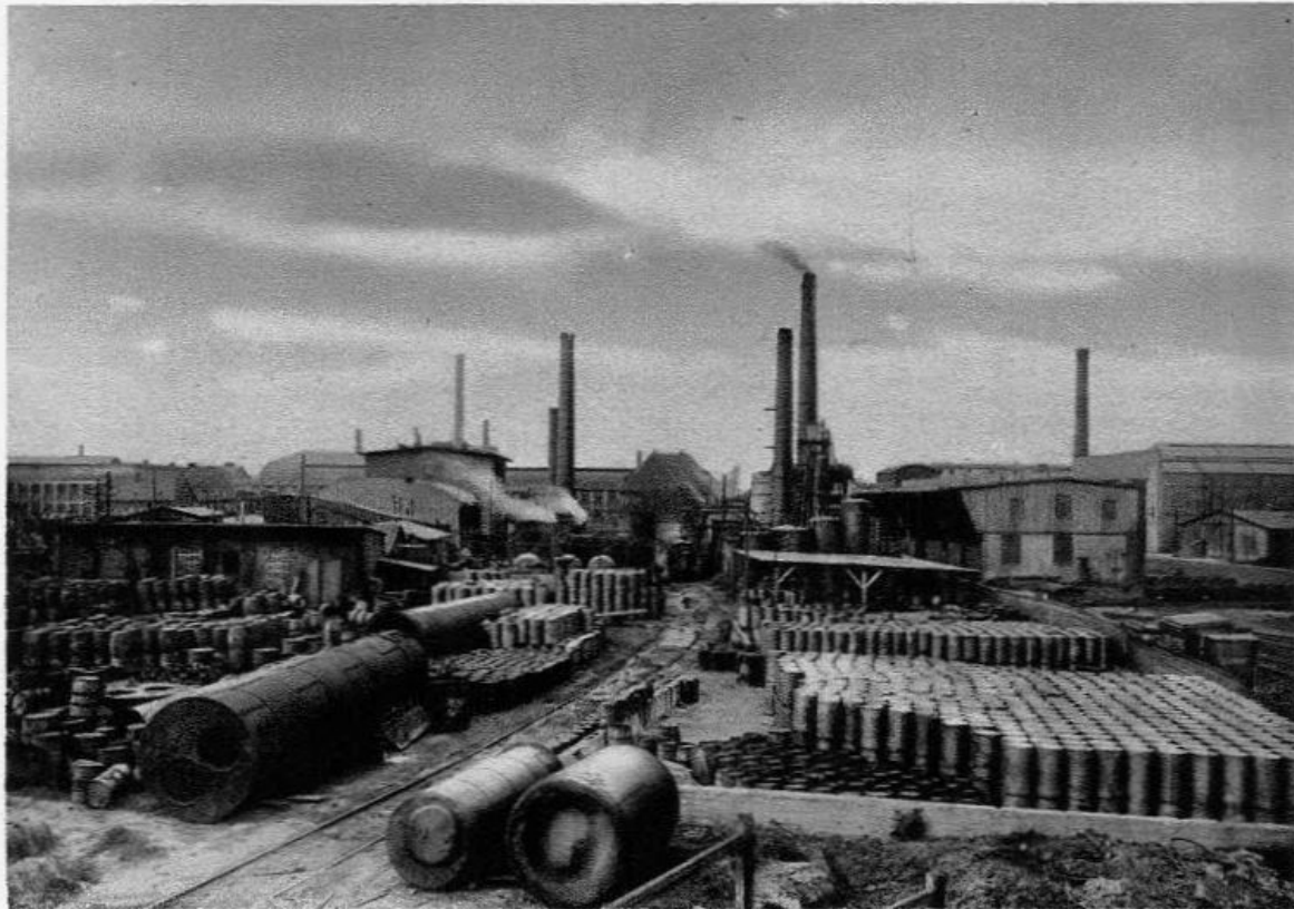
Teilansicht der Destillationsanlage
