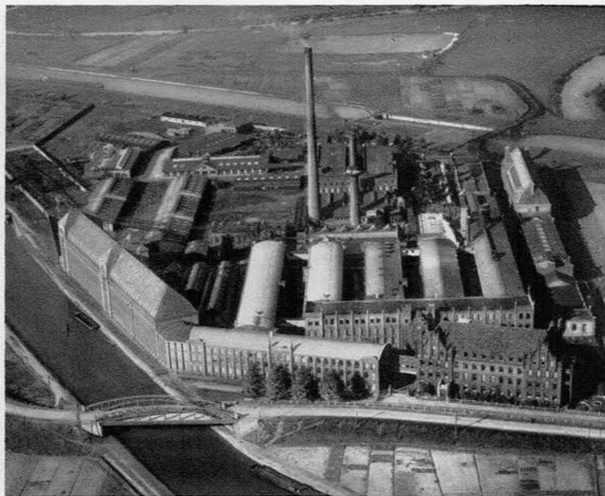
Die Werksanlagen im Jahre 1927 nach einer Flugzeug-Aufnahme
