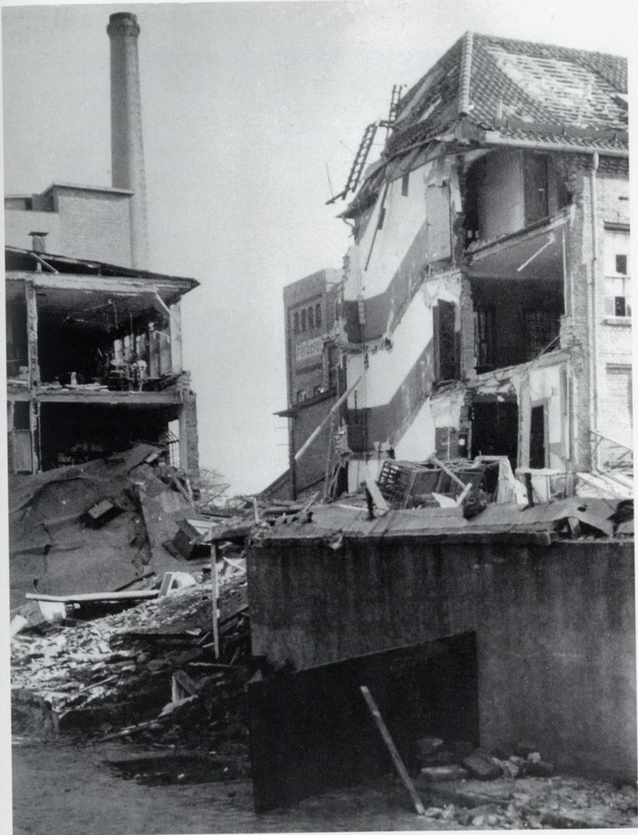
1943 Teilerstörung Fabrik Limmer
