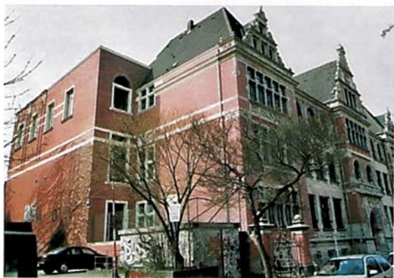
Beethovenstraße, ehemalige Humboldtschule, heute IGS
