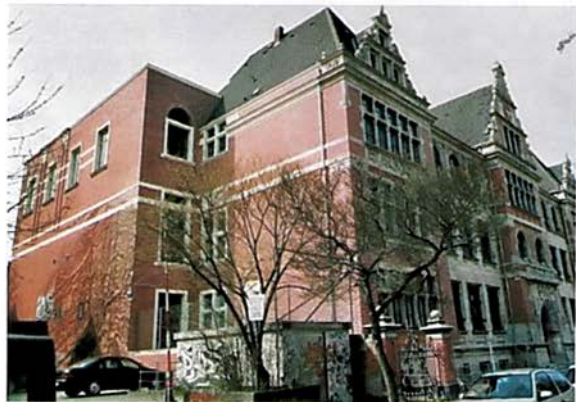
Beethovenstraße, ehemalige Humboldtschule, heute IGS
