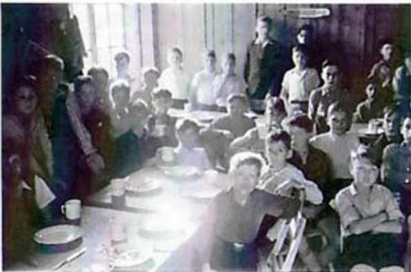
Speise- und Schulraum der Unterstufe
