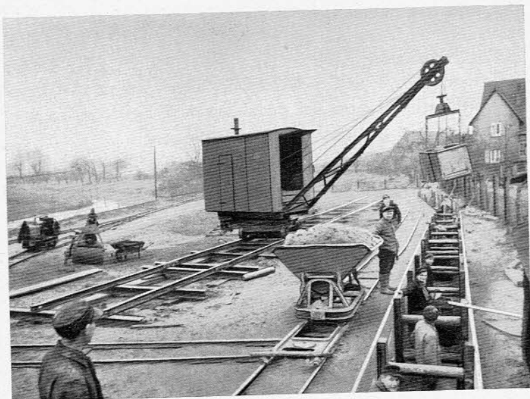
Kanalisationsarbeiten an der Kölner Straße
