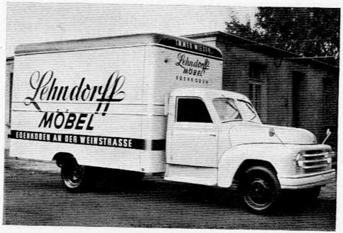
Möbel-Koffer-Aufbau auf 1,5-t-Hanomag-Fahrgestell
