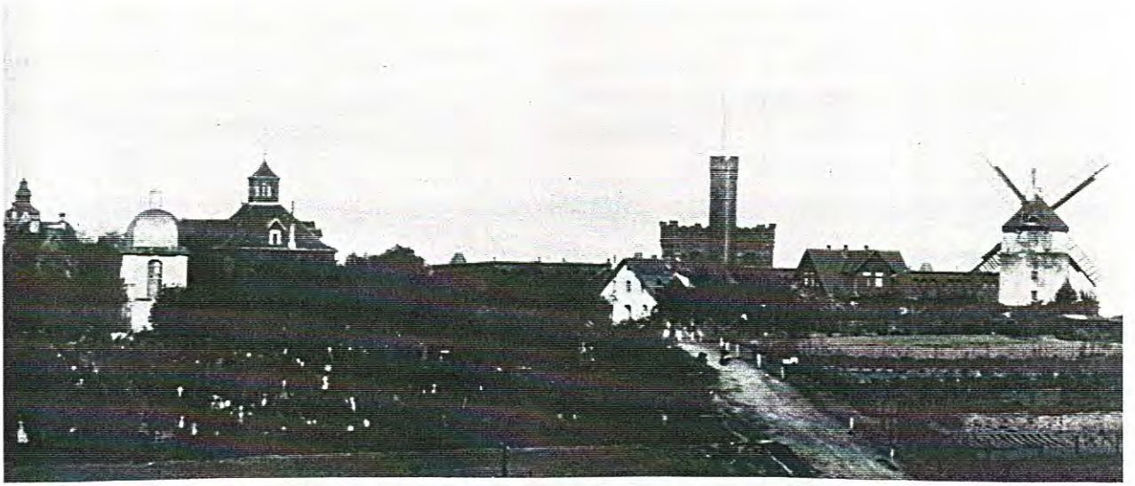
Aufnahme Körting 1916 - LINDENER BERG, gegenüber dem BERGFRIEDHOF mit KÜCHENGARTENPAVILLON (1914), Villa "OSMERS" (1900), WASSERWERK (1878), WINDMÜHLE (1392) als WEHRTURM (1651) als Windmühle umgebaut.
