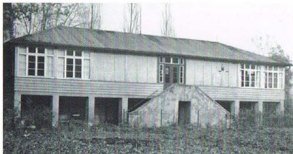
Alte Liegehalle vor dem Umbau
