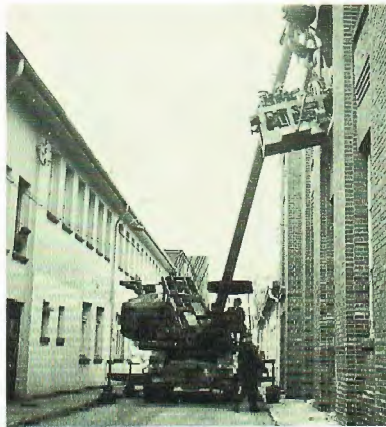
Oben: Produktions- schema für Sichozell aus den 50er Jahren. Unten: Installation einer neuen Pack- maschine 1955.
