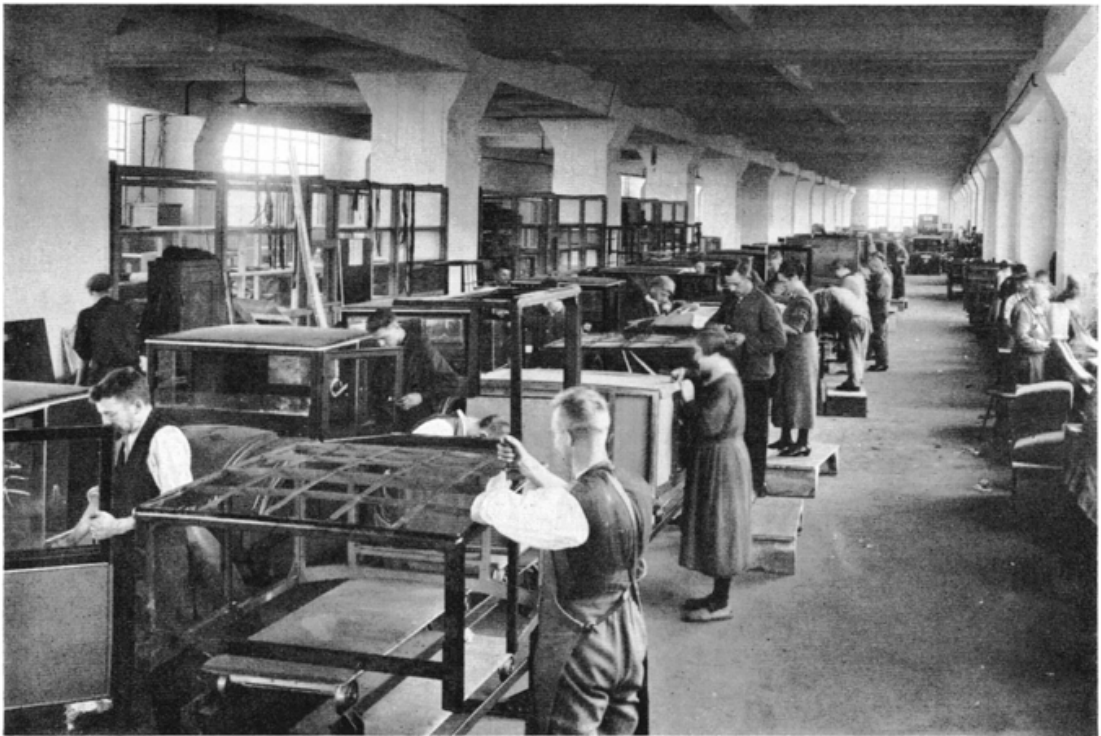
Nr. 60. Herstellung der Limousinen-Aufsätze am laufenden Band
