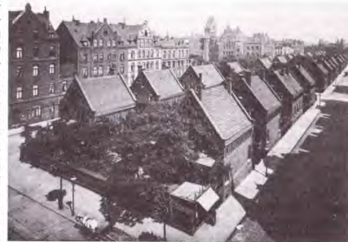
Arbeitersiedlung der Mechanischen Weberei zwischen Pfarrland- und Velvetstraße, 1911
