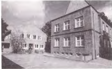
Das Unternehmerinnenzentrum, Hohe Strasse 9+11, später Vereinssitz, vor allen Umbauarbeiten; Baubeginn: Ende 1998.
